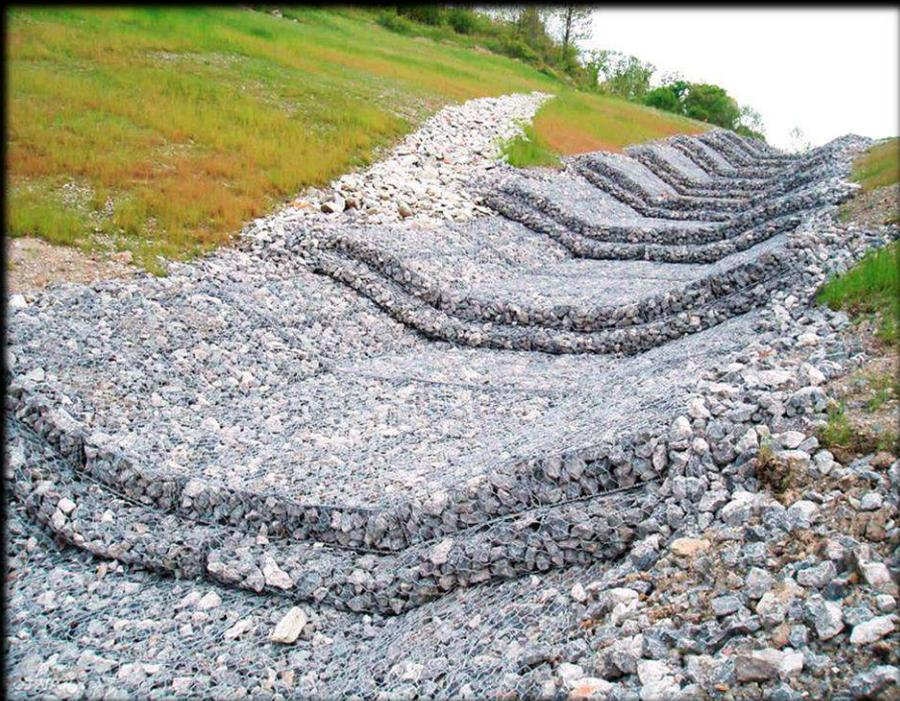
**МАТРАСНО-ТЮФЯЧНЫЕ ГАБИОНЫ** являются разновидностью объемных сеток с камнями. От остальных видов габрионных конструкций отличаются формой и размерами.
